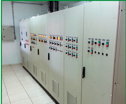
SISTEMA DE PARTIDA ESTRELA TRIÂNGULO / COMPENSADORA
